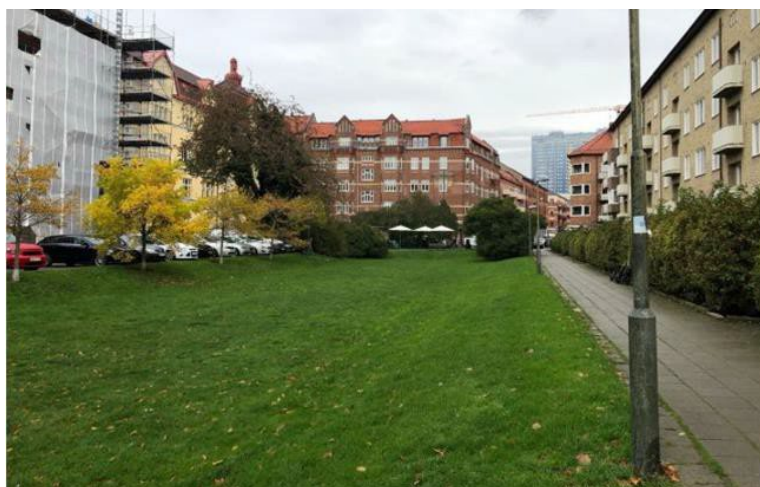
Figur 5 Torr damm. (Källa: Tyréns)
