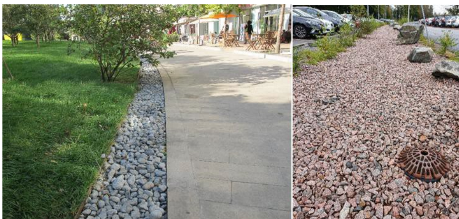
Figur 11 Makadamdike i anslutning till gånggata (vänster) och parkering (höger). (Källa: Tyréns)
