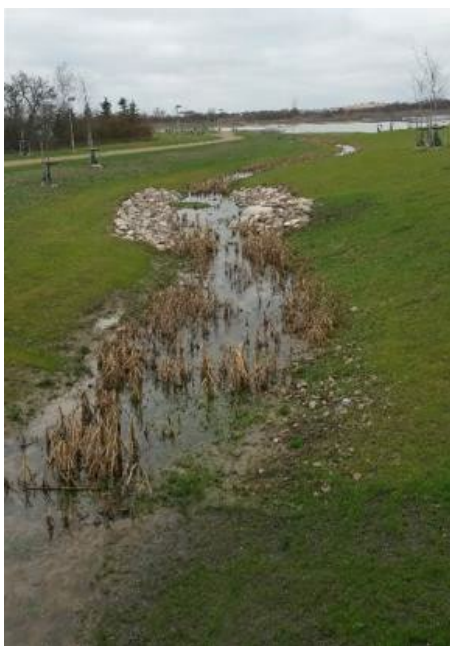
Figur 9 Svackdike. (Källa: Tyréns)
